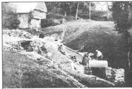
Úprava nové přípojně silnice mezi nově zbudovaným železobetonovým viaduktem a staré silnice na Vitanov v roce 1934. Silnice povede kolem později postaveného domku a obchodu pekaře p.Malečka a kolem domku Lesákových (na snímku).
