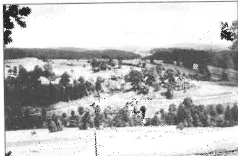
Nově zbudovaná komunikace na levém břehu budoucího přehradního jezera z Pastvin do Klášterce v roce 1936.
