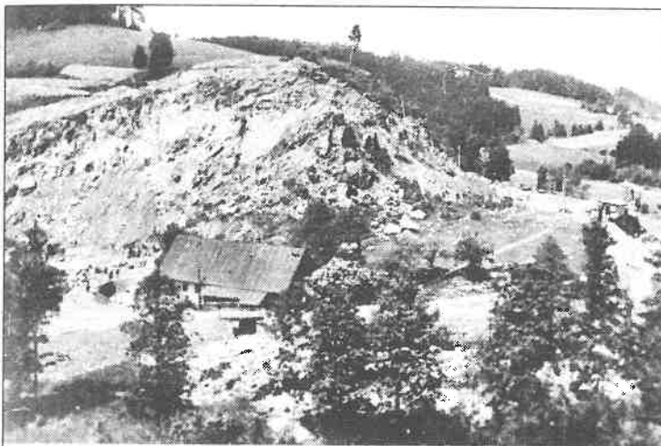
Celkový pohled na Pšondrův lom bezprostředně před uzavřením v červnu 1938.
